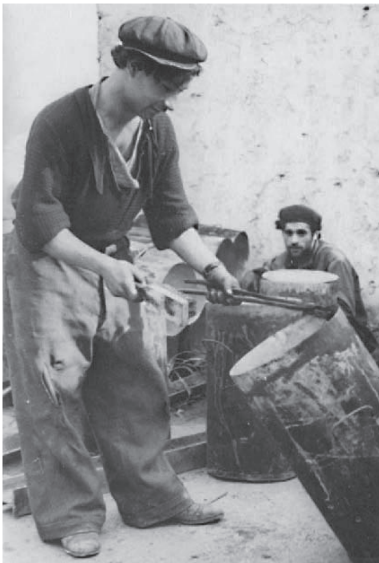
Изготовление баллонов под сатураторные установки для газированной воды. На переднем плане Жора сын Брэтьяно, на заднем плане Риста.
